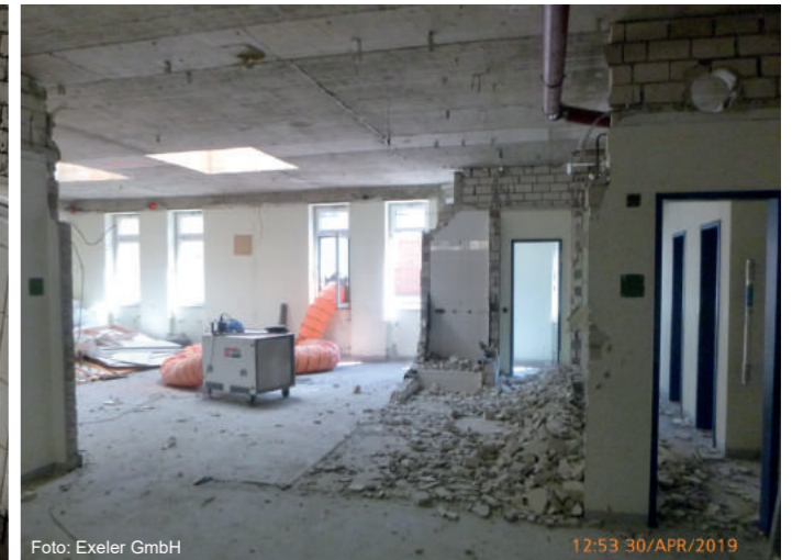
APRIL 2019 | Abrissarbeiten beginnen: Das Gebäudeinnere wurde in den Zustand eines Rohbaus zurück versetzt.
