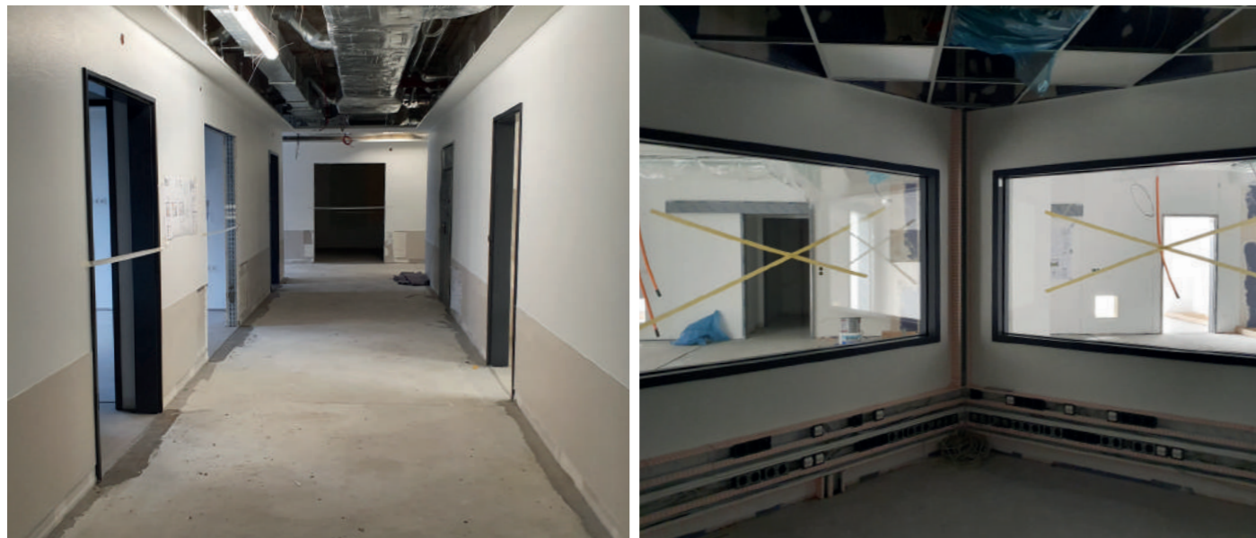
FEBRUAR 2020 | Zwei Monate vor Eröffnung: Viele Gewerke arbeiten gleichzeitig: Maler, Fliesenleger, Elektriker ..
