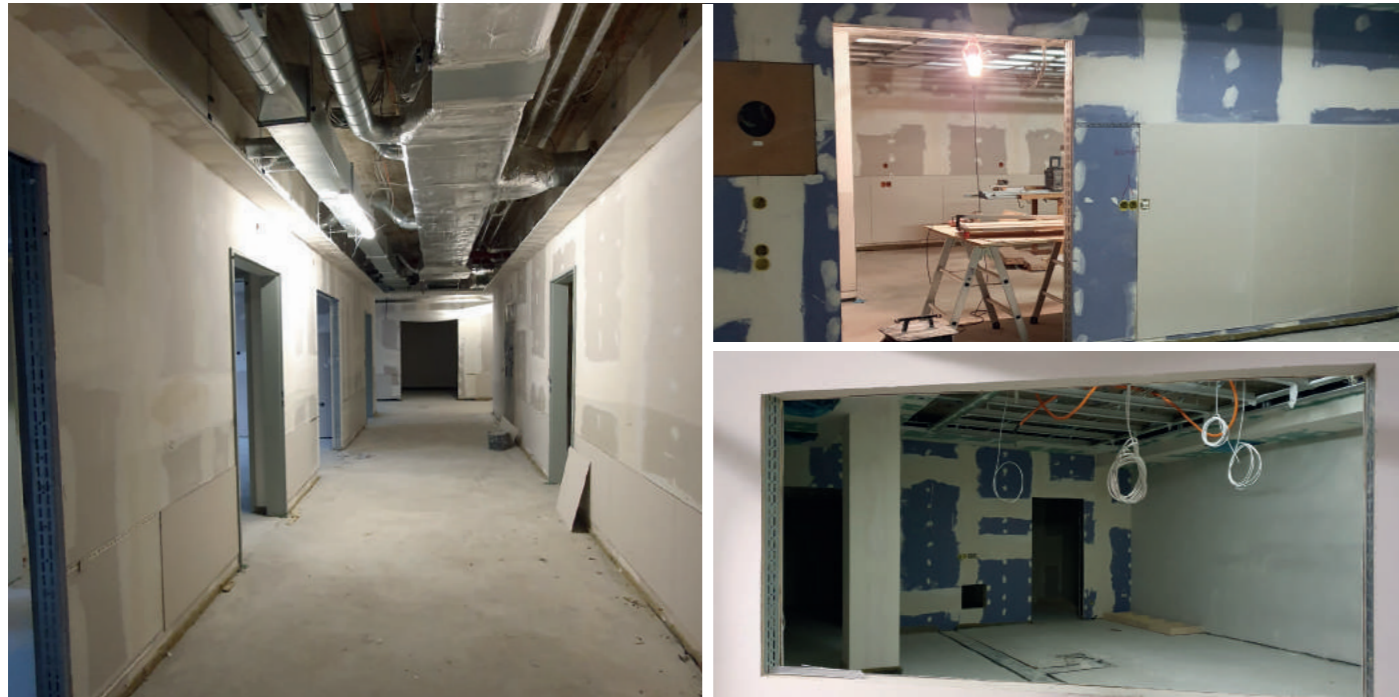
NOVEMBER 2019 | Rohbau: Durch das Einsetzen von Wänden sind Räume/Flure entstanden, wo vorher eine Freifläche war.
